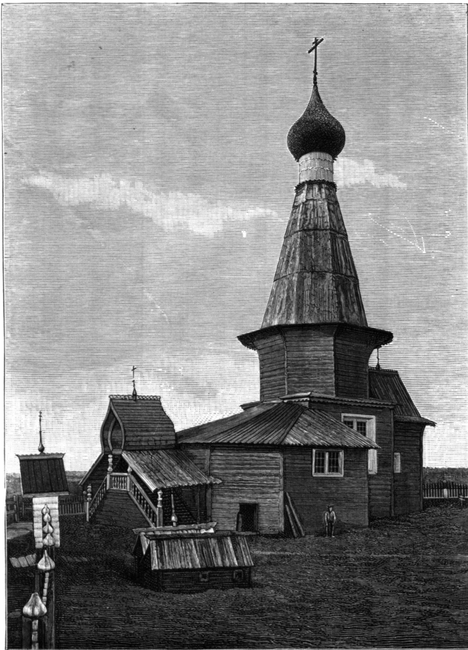
Церковь Св. Николая Чудотворца, постр. въ 1700 г. въ селѣ Малошуйскомъ, Арханг. губ., Онежскаго уѣзда.
